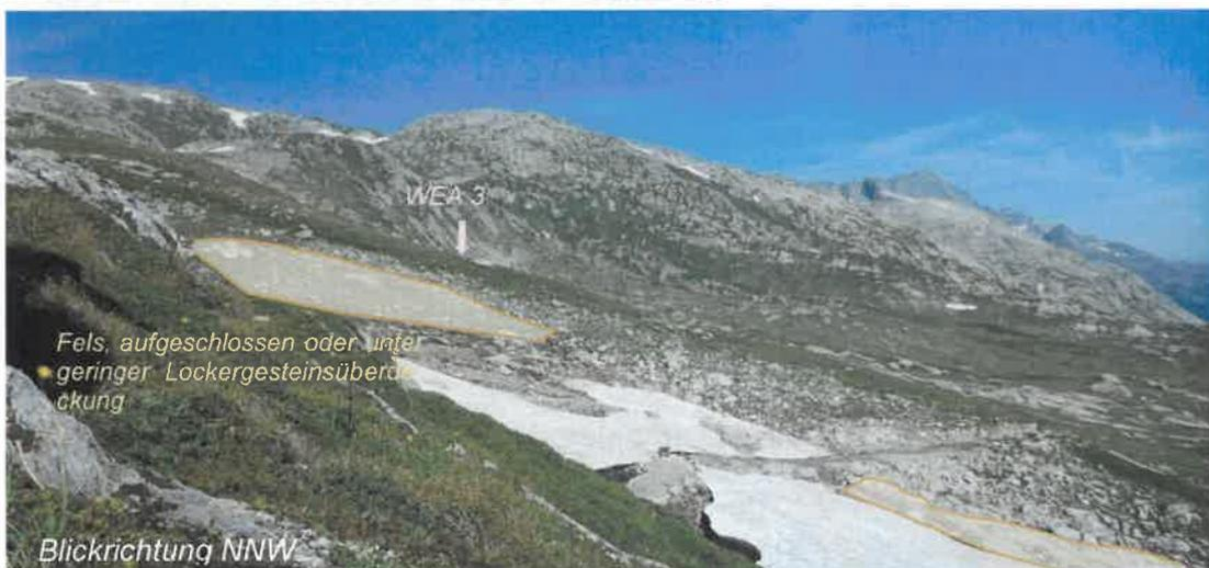
Foto 4: WEA 3: Auf topografischem Rücken aus mind. teilweise Moränenmaterial, Lockergesteinsmächtigkeit kann lokal höher (> 2.5 m) sein.
