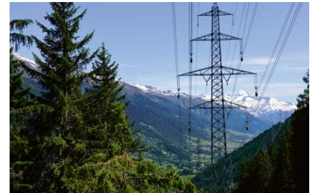
Die neue Höchstspannungsleitung zwischen Ernen und Ulrichen ist in Betrieb.
