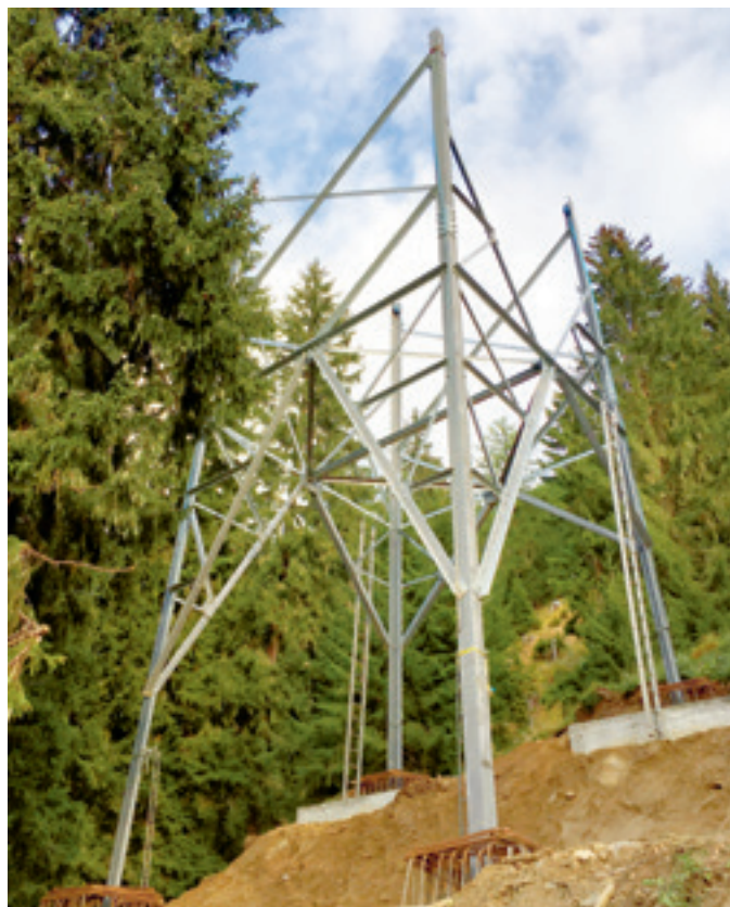
An 30 von 57 Masten wurden die Mastunterteile bereits montiert.
