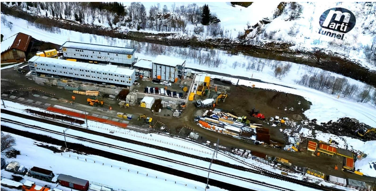
Installationsplatz Realp: Stand April 2024
